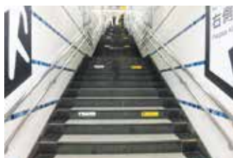
階段蹴込み部分の通行区分表示
