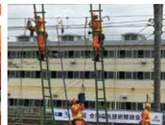
電気部門での技術競技会：架線が切れたことを想定した復旧作業の様子
