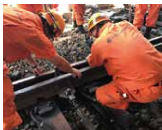
分岐器レール交換作業の様子
