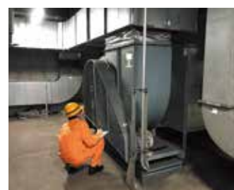
換気設備動作・異常音確認
