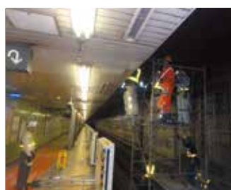
夜間作業による天井材検査
