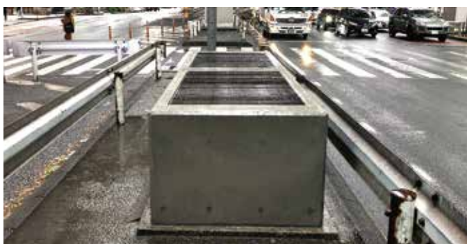
対策後の換気口
