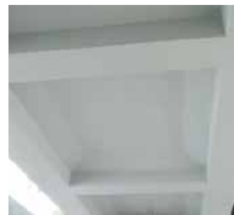
高架橋長寿命化対策後
