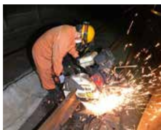
レール切断作業の様子
