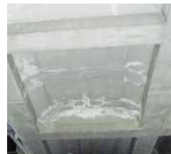
高架橋長寿命化対策前
