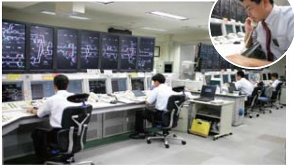
↑モニターで鉄道全線の運行状況を把握し、トラブル発生時には適切な指令を出し、正常運行の確保に努めます。（右上）運行中の乗務員や鉄道各社と無線や専用電話で連絡を取り合うことができます。
