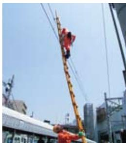
信号装置や踏切保安設備、列車無線、非常停止ボタンなどを定期的に検査しています。また、列車や駅へ電力を安定供給するため、27カ所の変電所をはじめ、電車線や高圧配電線などの保守・管理も行っていきます。
