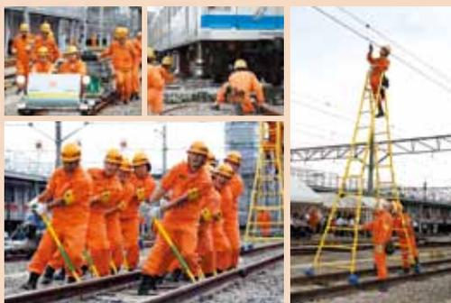
4 線路や架線などの復旧完了の連絡を受け、架線への送電を開始し、運転再開の準備を始めます。
