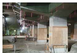
補強中の祐天寺駅の高架橋
