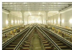
地下化工事の渋谷駅～代官山駅間
