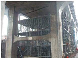
耐震補強工事中の高架橋
