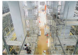
高架下耐震補強工事
