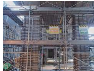
耐震補強工事中の高架橋
