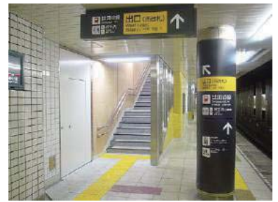
通路を増やして避難経路を確保した三軒茶屋駅
