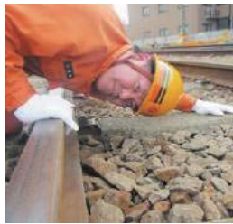
線路に異常がないか目視で確認します。
