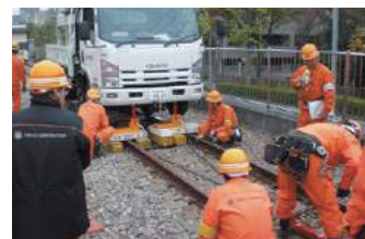
〈電気部門での技能講習会の一例〉線路と道路の両方を走ることができる軌陸車の脱線復旧訓練を行い、異常時に対応できるスキルを身に付けます。
