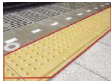
内方線付き点状ブロック
