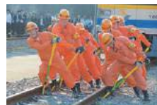
線路(軌道)の幅を直す軌道整正。複数の保線技術員が力合わせて整えます。
