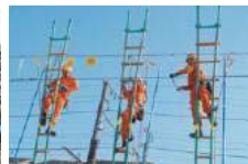
架線が溶損した際の復旧訓練。電気部の担当の技術員が速やかに復旧を行います。
