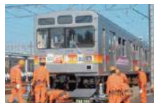
脱線した車両の復旧訓練。油圧ジャッキを使って車両をジャッキアップし、線路上に復旧させます。
