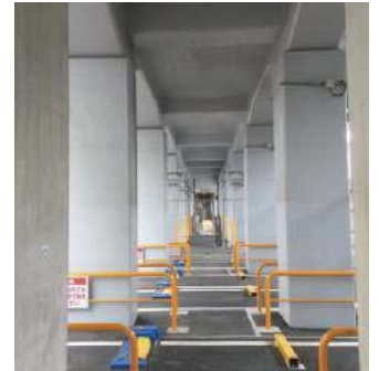
耐震補強工事済の高架橋
