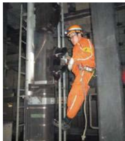
安全帯を用いて安全を確保し、信号設備を確認します。
