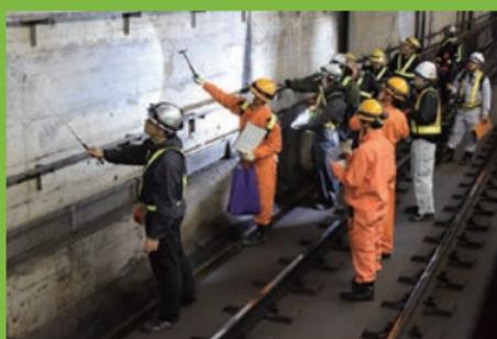
トンネル壁面の亀裂など不具合を点検
