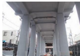
耐震補強工事完了後の高架橋
