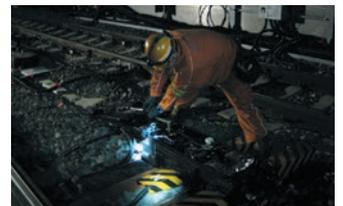
信号設備検査(転てつ器検査)
