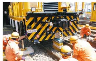
保線部門での技術伝承の一例：夜間作業で活躍する保守用車の方が一のトラブルに備え、年に2回、脱線復旧訓練を実施し、異常時に対応できるスキルを身に付けます
